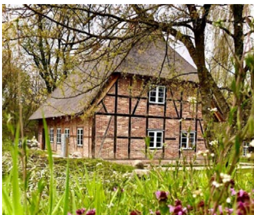
Das Haus der Stiftungen am Küchengarten.
